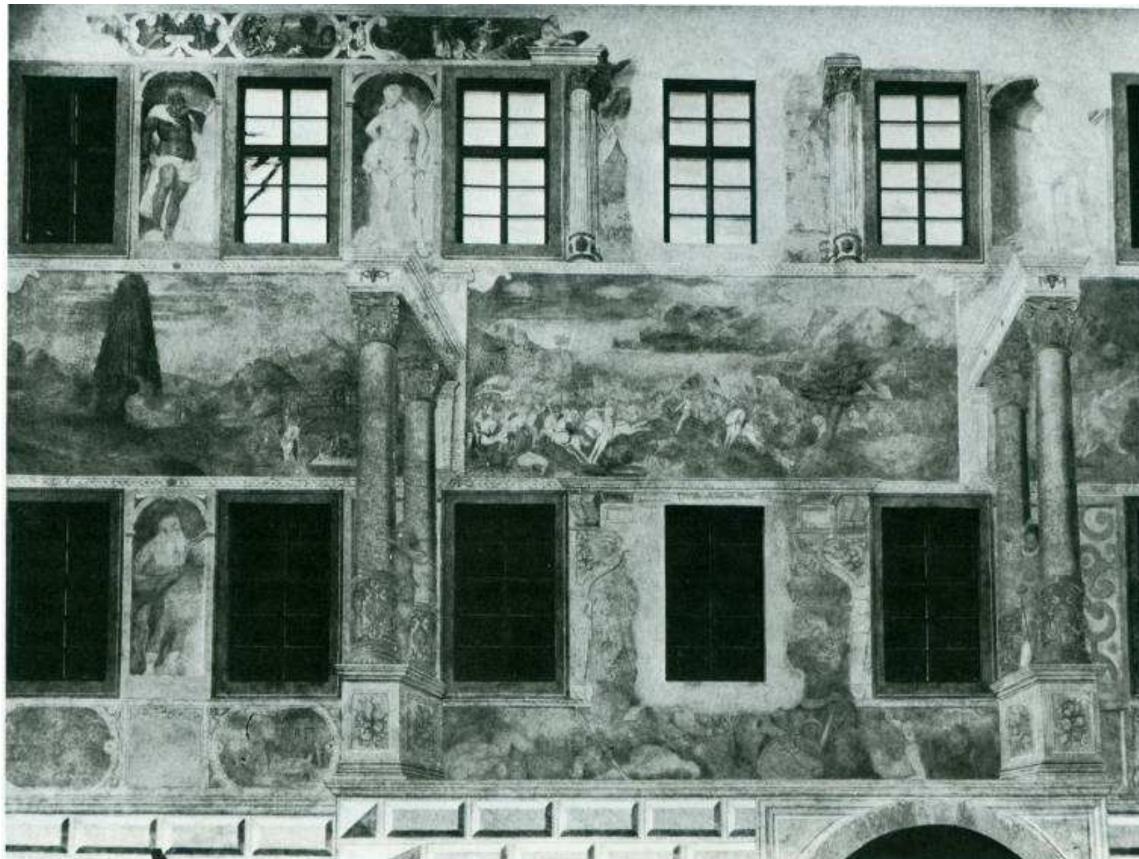
Iluzivní nástěnná malba na nádvořní fasádě vstupního křídla Bechyňského zámku 1585 - 1587
